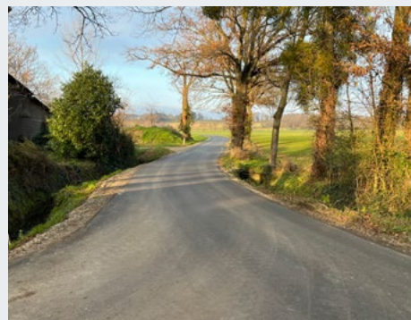
/ Le secteur de la Loulais a bénéficié de ces travaux de modernisation.
