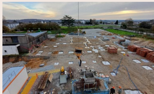
/ Les travaux ont commencé depuis plusieurs mois.
