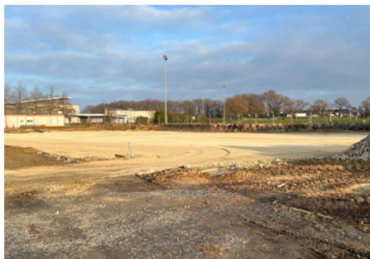
/ La nouvelle salle de sport sera située à côté du lycée Jean Brito.
