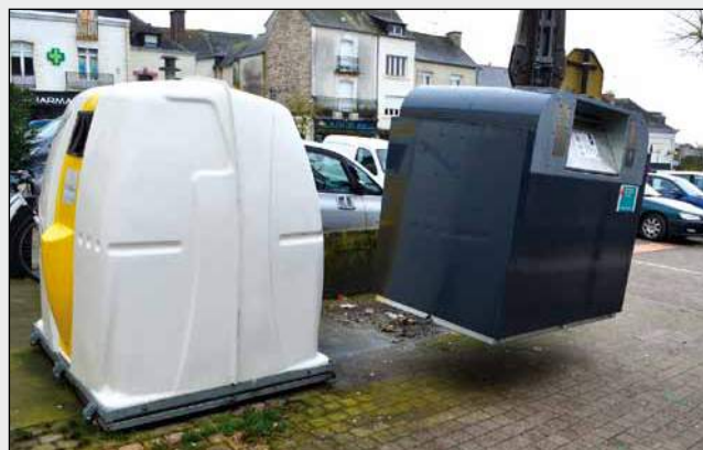
L'installation du nouveau conteneur, sur la place de la République.
